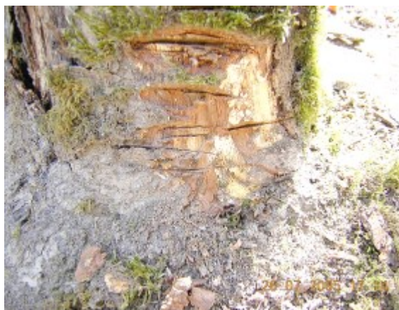
Figure 5 : Présence d'une pourriture blanche visible par grattage de l'écorce du collet (ANPN)
